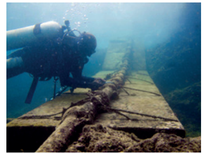
KONTROLA PODMORSKÉHO KÁBLA PRI POBŘEŽÍ USA
